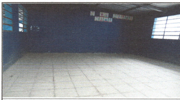
Foto 5: Instalación de piso ceramico
