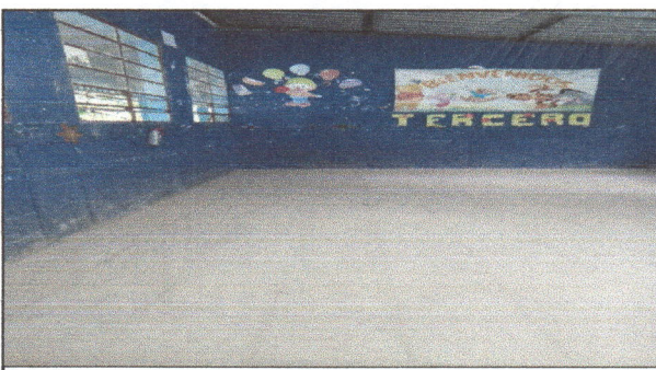
Foto 6: Instalación de piso ceramico
