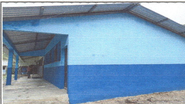
Foto 2: Paredes reparadas, repelladas y pintadas.
